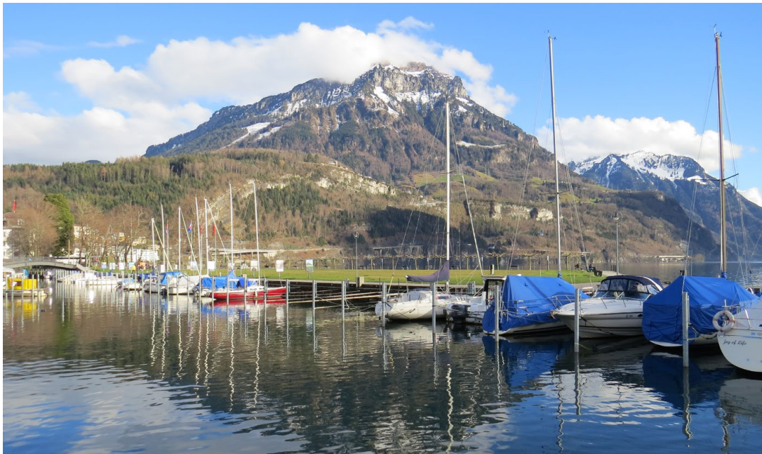
Föhnhafen mit den sanierten Bootspfählen
